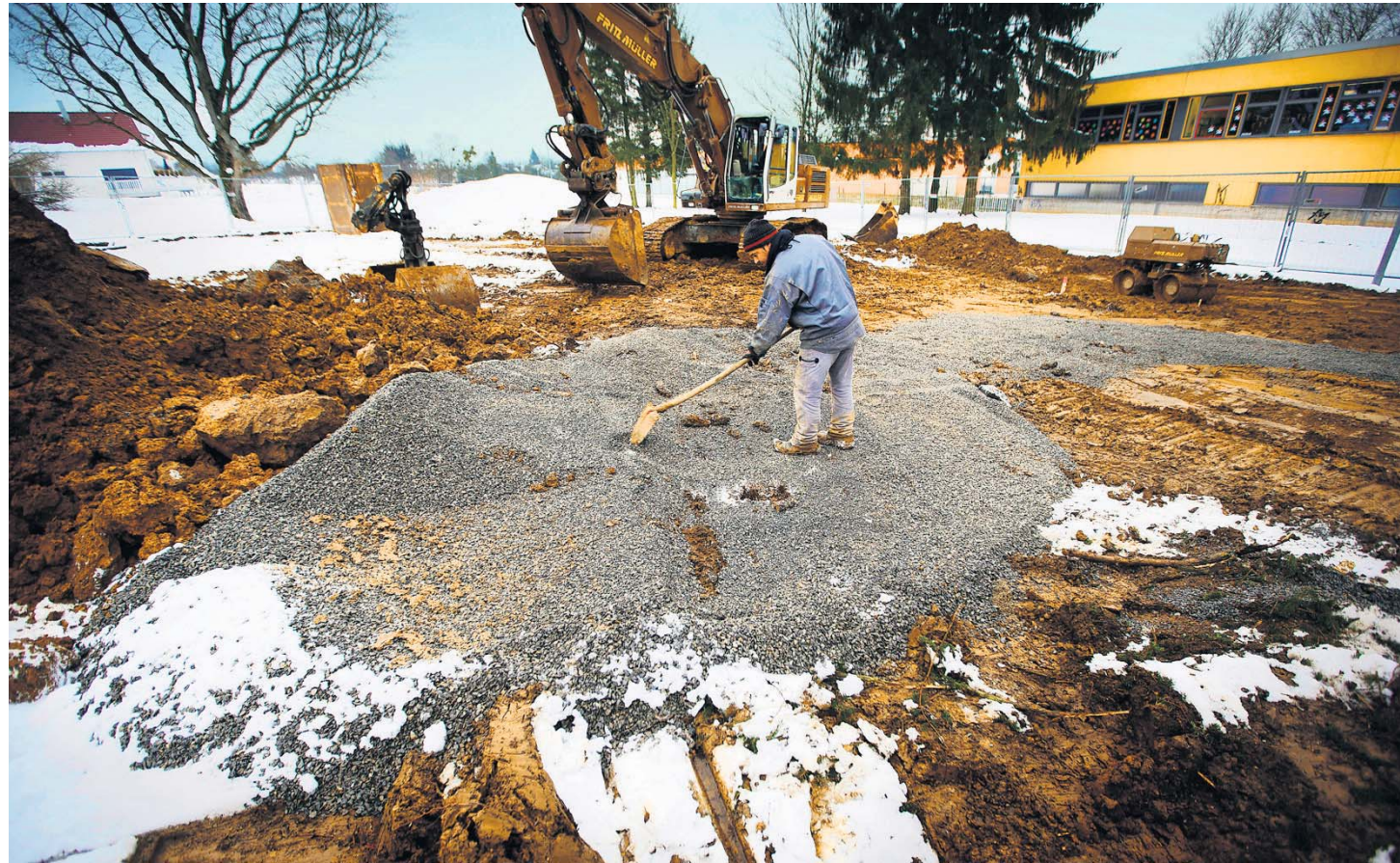
Die Bauarbeiter legen bereits vor dem offiziellen Spatenstich los.
